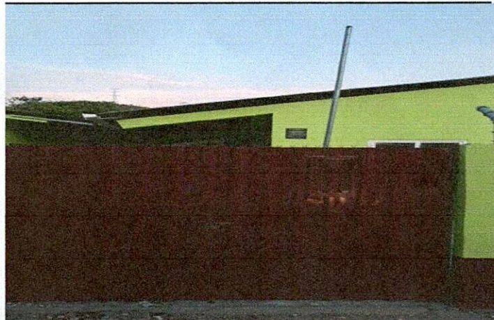
Foto 4: SUSTITUCIÓN DE PORTON
