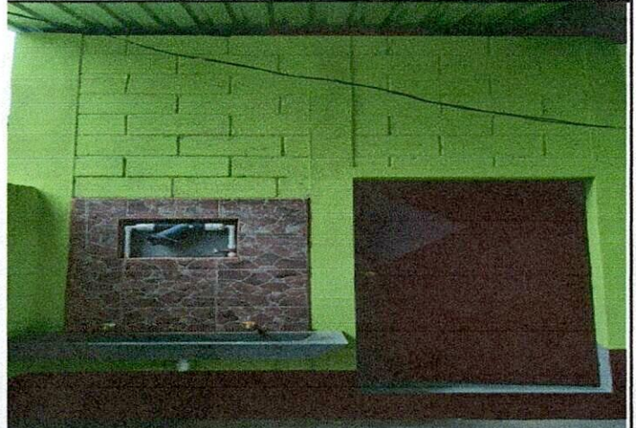
Foto 2: MEJORAMIENTO DE PAREDES
